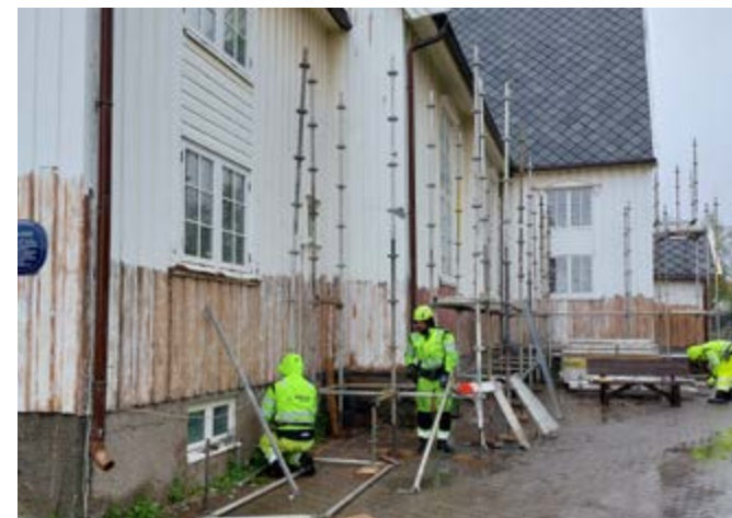
Stillasene rundt Mo kirke ble satt opp i vår. (Foto: Geir Gisnås)
