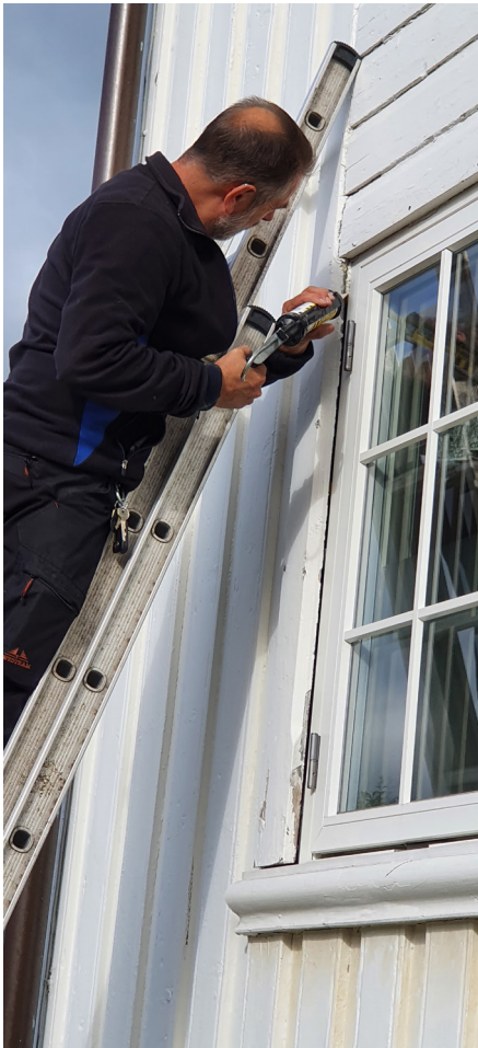
Å skifte vinduer hører strengt tatt ikke til jobben, men i sommer har han gjort det også, og da må det litt fugging til.
